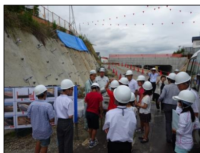
桜ヶ丘沓掛線の工事現場
