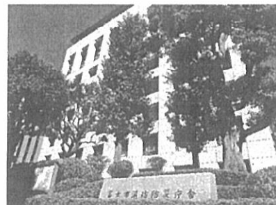
富士市・富士宮市消防指令センターがある富士市消防防災庁舎
