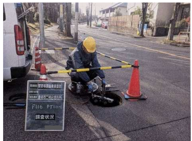
マンホール点検調査の様子
