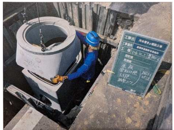
污水管きょ埋設工事の様子
