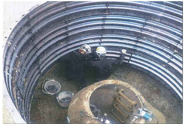
污水管きょ埋設工事の様子
