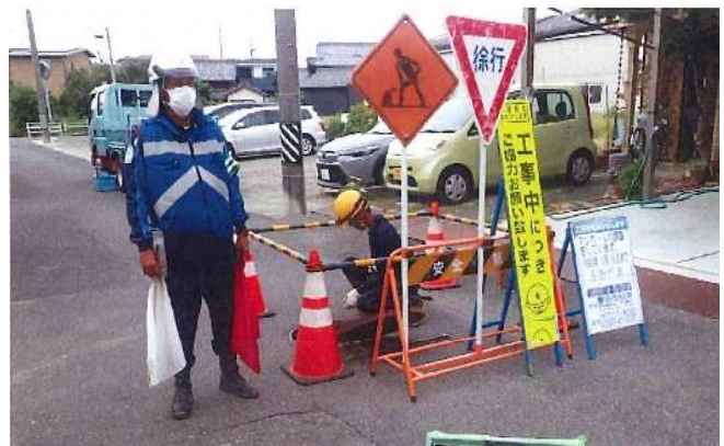
マンホール点検調査の様子
