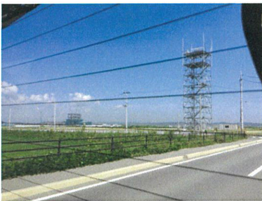
⑧建設中のロボットテストフィールド
