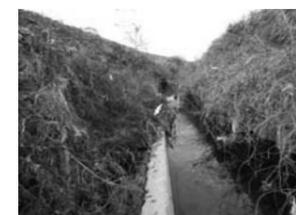
崩壊した二級河川護岸。崩壊したコンクリート護岸も同じような経年劣化による箇所が確認される
