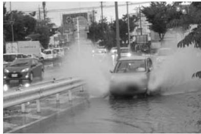
自動車事故にもつながりかねない路面水溜まり
