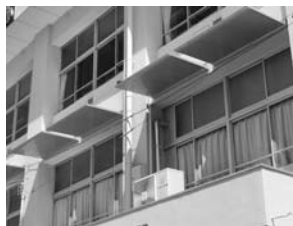
豊田市内の小学校に設置されているひさし
