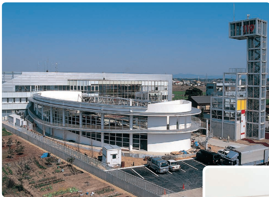
消防庁舎(平成10年撮影)
