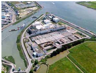
写真6-1 境川浄化センター
