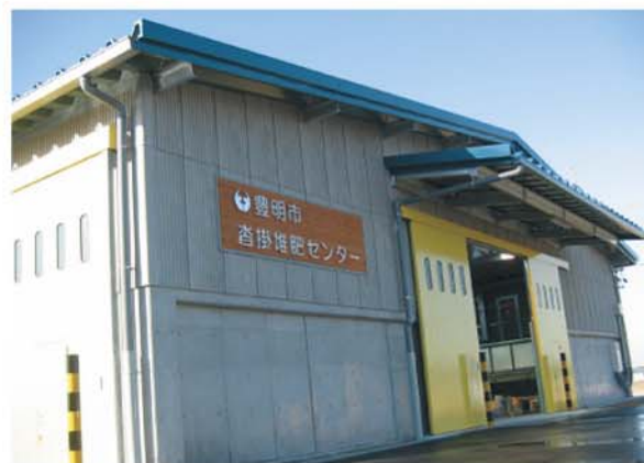
堆肥センター
