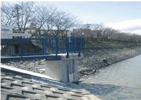
三崎池に設置された洪水調節用のゲート
