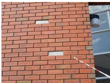
■外壁（レンガ張り）の状況
