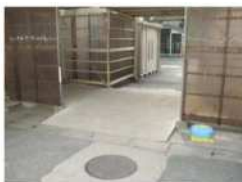
コンクリートを打設し段差を解消 〔神奈川県横浜市立羽沢小学校〕
