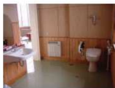
車いすで方向転換ができる スペースを確保したトイレ 〔秋田県男鹿市立北陽小学校〕
