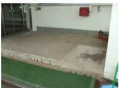
コンクリートを削り段差を解消 〔神奈川県横浜市立羽沢小学校〕
