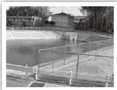
二ツ池の洪水調整機能設置
