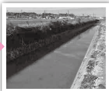
着手後(堆積土砂の撤去完了)
